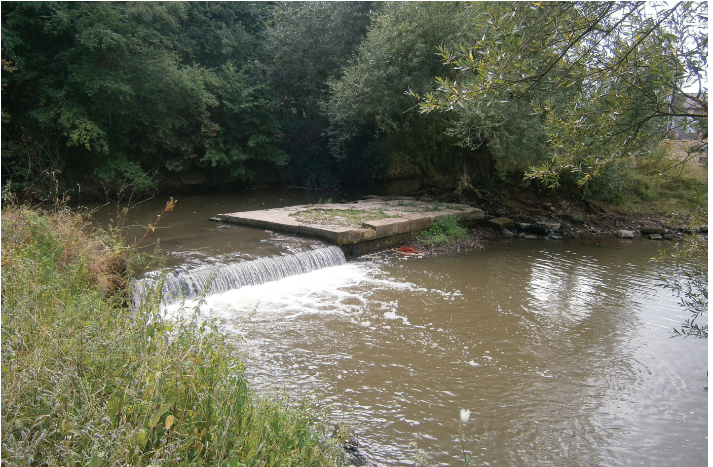
Hindernis für Fische: Das Wehr in Windecken wird umgebaut.
