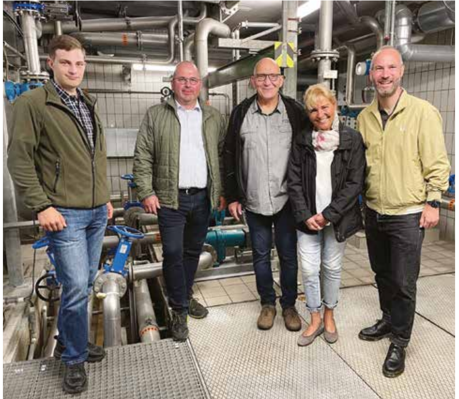
Inmitten eines hochkomplexen Systems: Stellvertretender Abwassermeister Alexander Ehl, Erster Stadtrat Rainer Vogel, Abwassermeister Dirk Baumann, Stadtwerkeleiterin Daniela Weißner und Bürgermeister Andreas Bär begrüßten die Gäste zum Tag der offenen Tür auf der Kläranlage Windecken.
