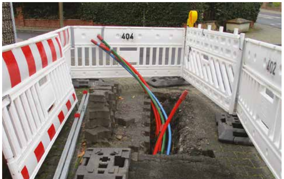
Abgerollt: Rund 80 Kilometer werden am Ende unter den Bürgersteigen der Stadt verschwinden sein.
