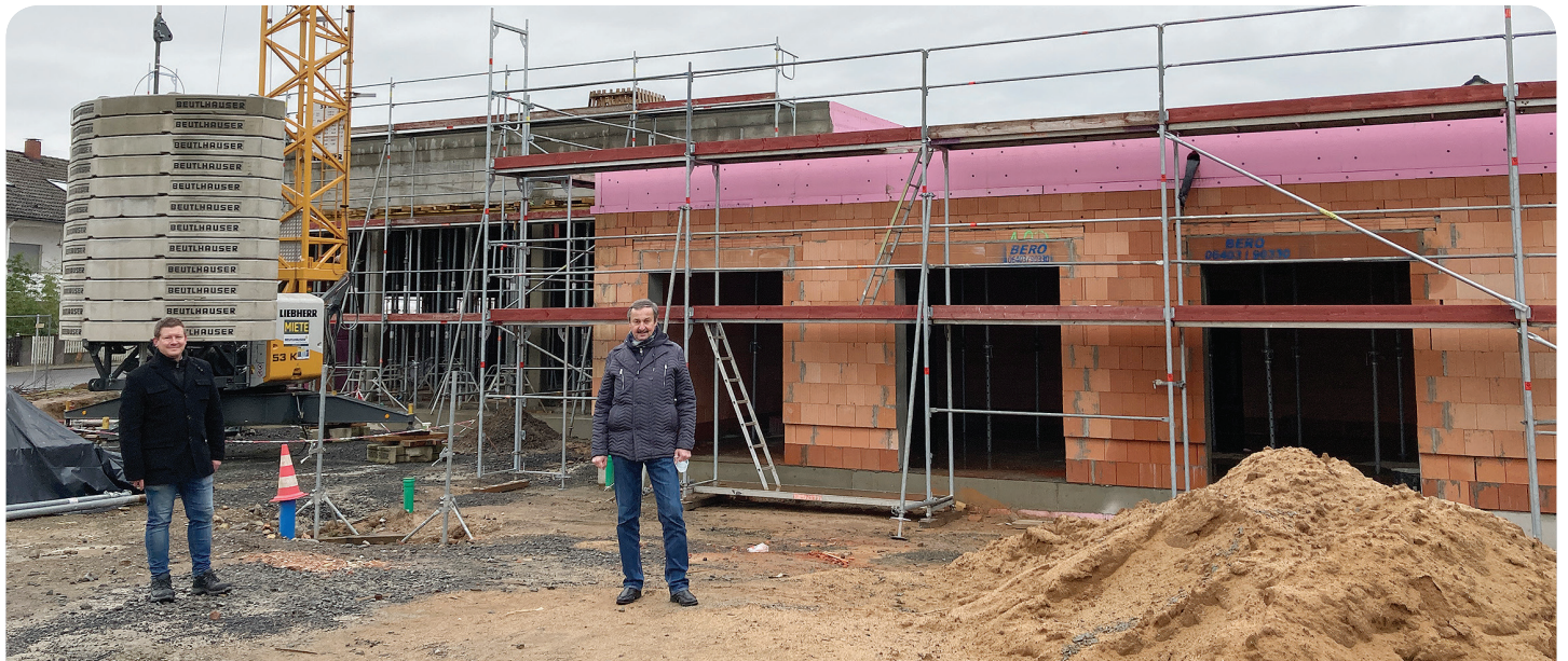
Bürgermeister Gerhard Schultheiß (rechts) und Architekt Leon Gierhardt vor dem neuen Feuerwehrgerätehaus in Eichen mit Blick auf den Schulungsraum und die Fahrzeughalle (links).
