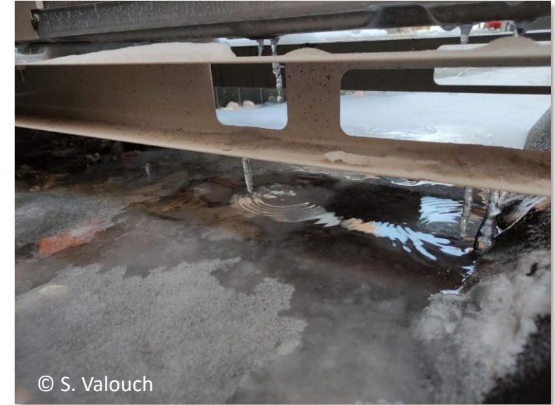
Wärmepumpe taut nach Bedarf ab
